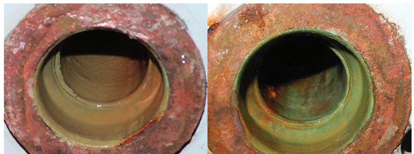
동관에 형성된 물때막이 링 설치후 제거된 모습
