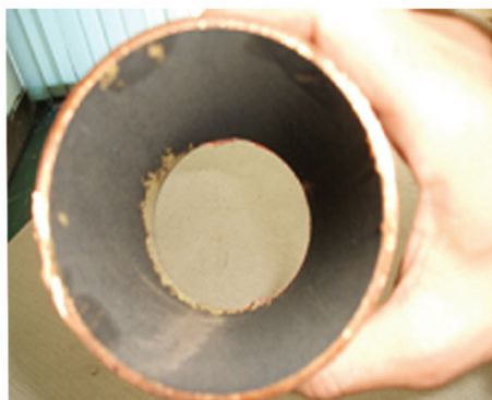
<메루스링 설치전 사진>
