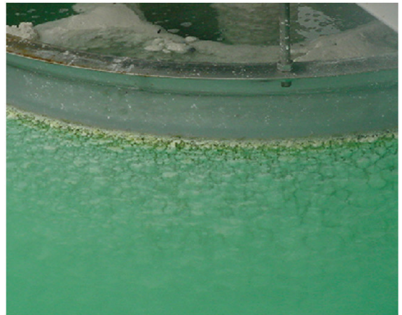
설치전 침전조 내통 상태
