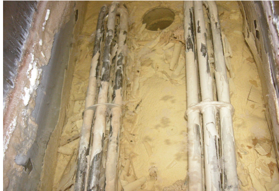
지하수를 가열하여 사용하는 설비에 형성된 스케일 열효율과 정비상에 많은 문제를 야기하고 있다.
