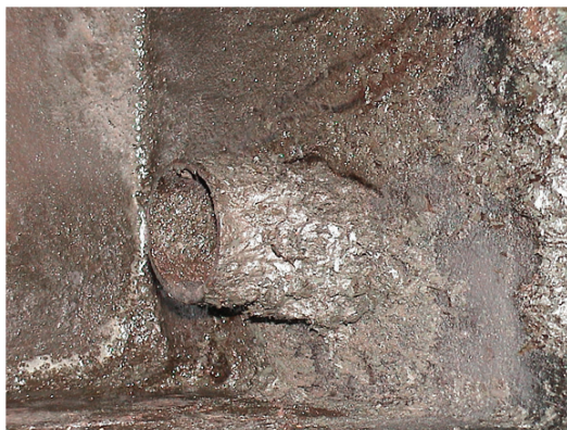
설치전 오일 탱크 내부
